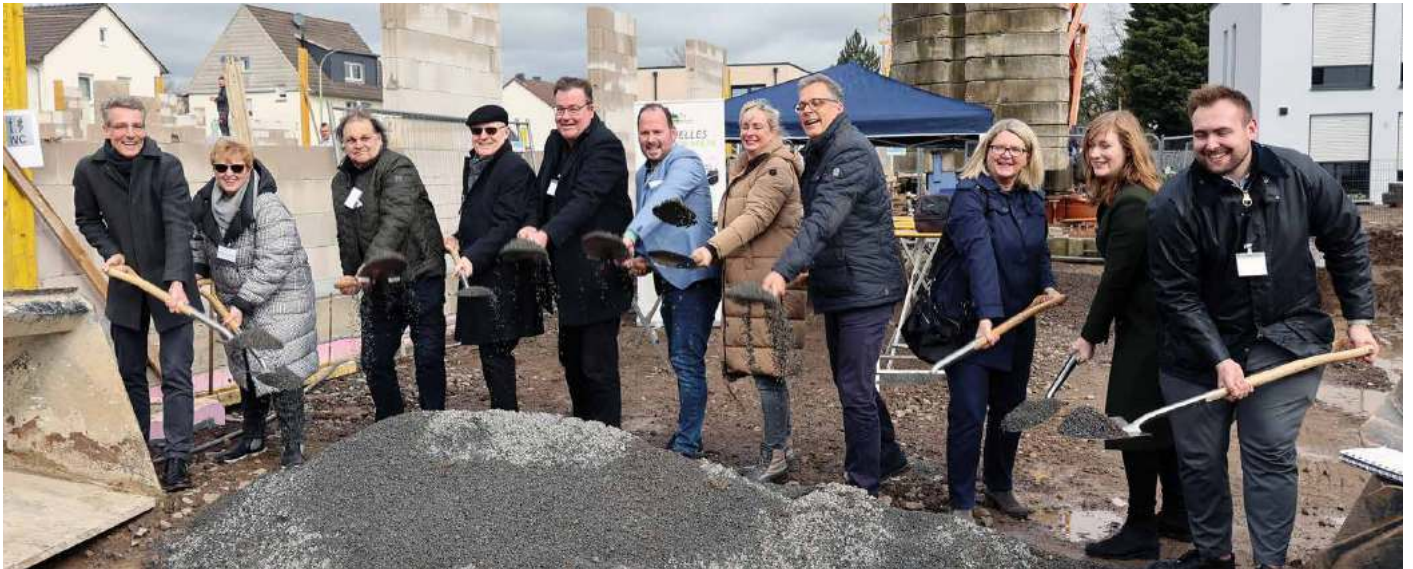
Absolvierten den Spatenstich für eine neue Wohnstätte für Menschen mit Behinderung in Zülpich: Stadtentwickler Christoph Hartmann, Bauherrin Katharina Paffendorf, Architekt Rainer Graßmann, HPZ-Aufsichtsratsvorsitzender Helmut Habscheid, HPZ-Geschäftsführer Christian Pfaff, HPZ-Geschäftsführer Philipp Krosch, Melanie Sewell (LVR), Bürgermeister Ulf Hürtgen, Anja Nußbaum (LVR), Johanna Wolny (LVR) und Lennart Paffendorf. Bild: Michael Thalken/Eifeler Presse Agentur/epa
